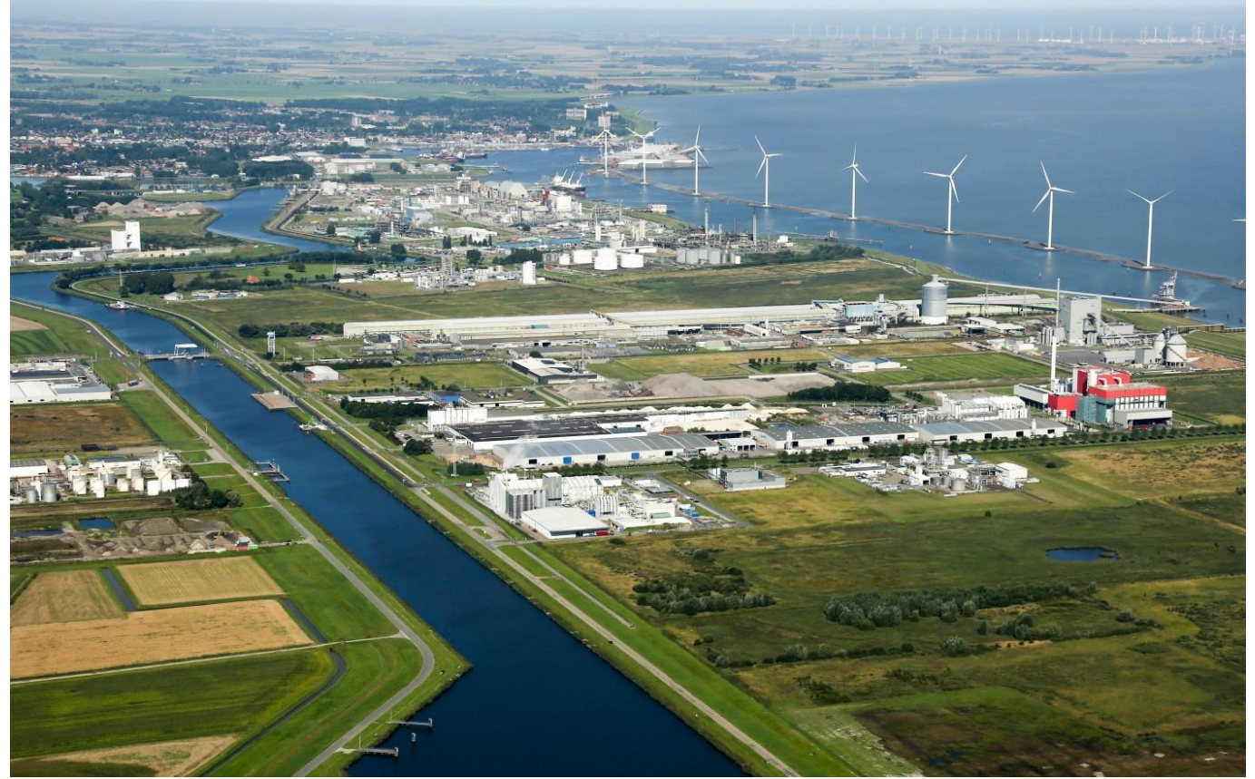
Groningen Seaports – Delfzijl & Eemshaven
